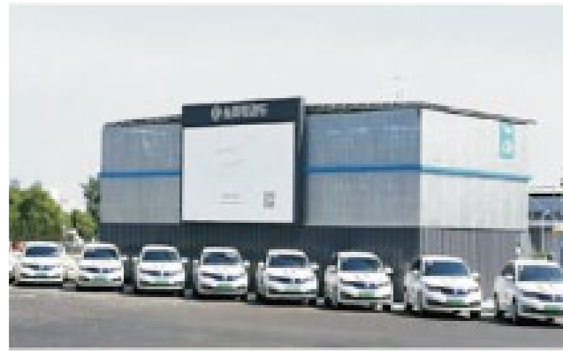
■ 东风汽车立体车库微电网项目
