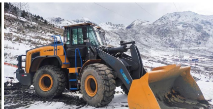
■ 高海拔电动工程车辆施工
