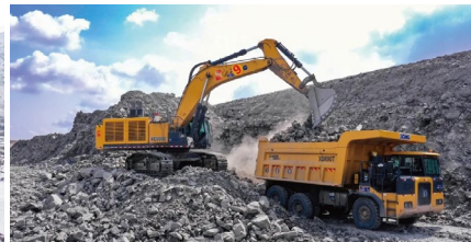
■ 矿区电动工程车辆施工
